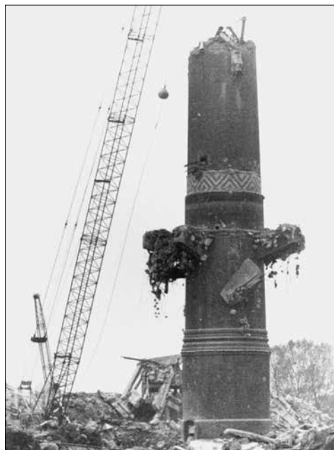
De sloop van de watertoren in 1983. Let vooral op de fraaie detaillering van het metselwerk in de vroegere fabrieksschoorsteen. (Foto Historisch Genootschap Wormer, archief Jacobus (Koo) Jonker)
