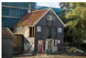
BEGIN RESTAURATIE WOODTHUIS, ZAANDIJK
